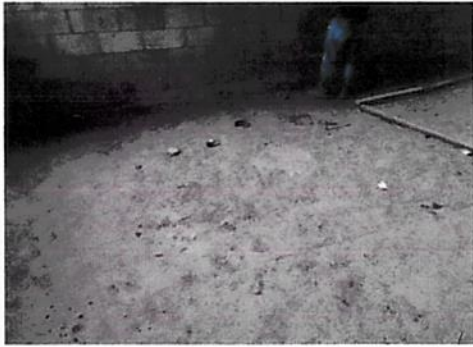
Foto 7: Implementacion de piso de torta de concret
