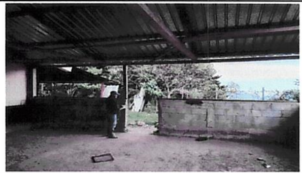
Foto 6: Sustitución de elementos de fijación
