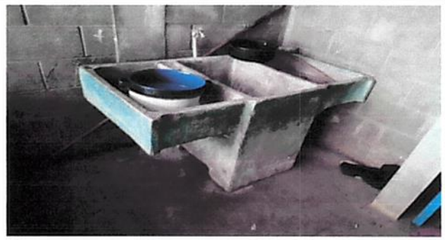
Foto 4: Sustitución de pila y tubería completa
