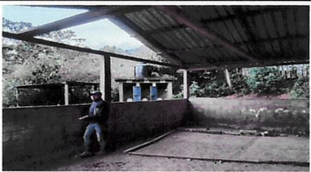
Foto 5: Sustitución de soporte de madera por metal
