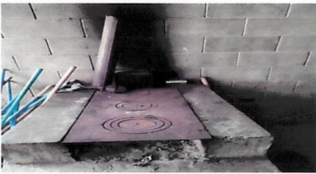
Foto 3: Sustitución de estufa
