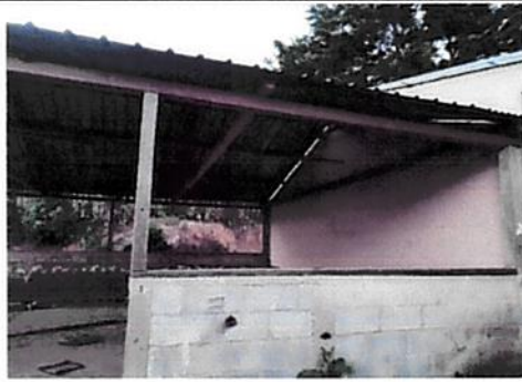
Foto 3: Pintura muros exteriores.
